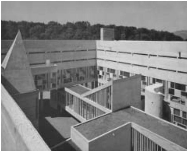
„Promenade architectural“ La Tourette; 1963, Henze, Moosbrugger, Josef Keller Verlag, S.42
