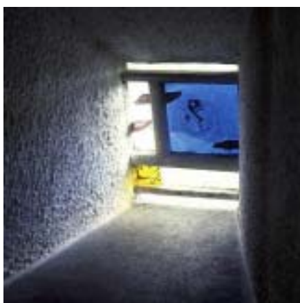
Fenster der Südfassade
